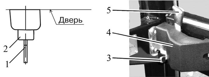
1 – ключ; 2 – кнопка; 3 – захват; 4 – замок; 5 – рычаг.
